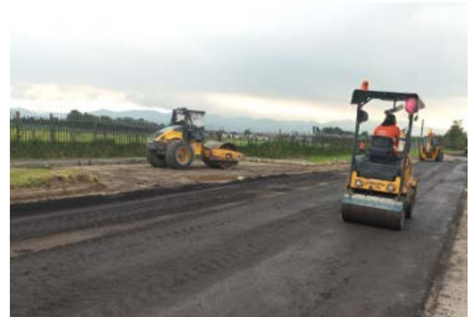
Adecuaciones de vías de acceso.
